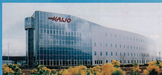
松本事業所 長野県 松本市 生産とメンテナンス拠点
