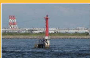
航路灯台制御盤 VCカプセル
